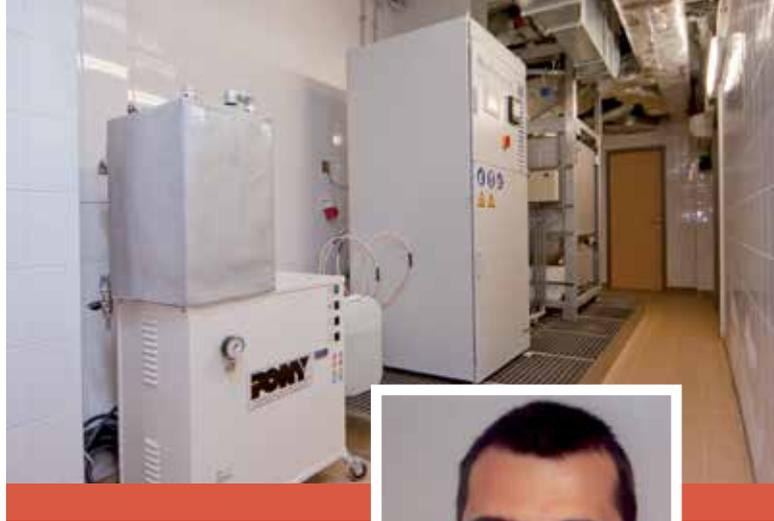
**Bild oben:** Das kompakte System benötigt mit 4,2 Meter Breite, 2,7 Meter Tiefe und abhängig von Zulauf- und Tankvariante 2,1 bis 2,8 Meter Höhe nur wenig Platz.
